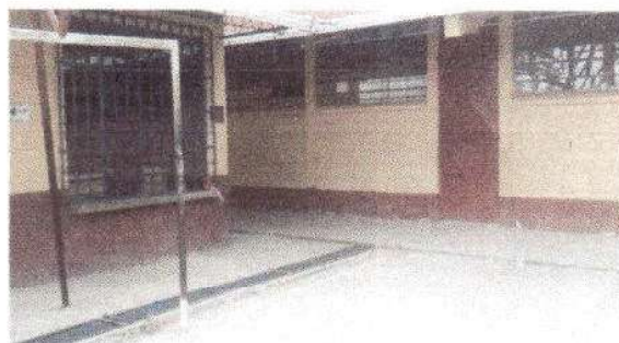
Foto 6: Cambio de chapa nueva para puertas instalada.
