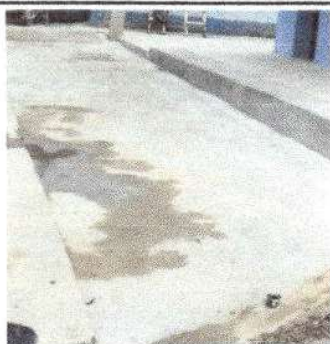
Foto 3: Piso de torta de concreto terminado.
