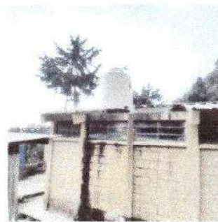
Foto 2: Instalacion de deposito de agua de 1,100 litros terminada.
