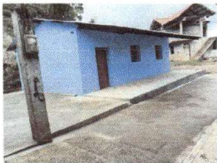
Foto 1: Techo de lamina terminada.
